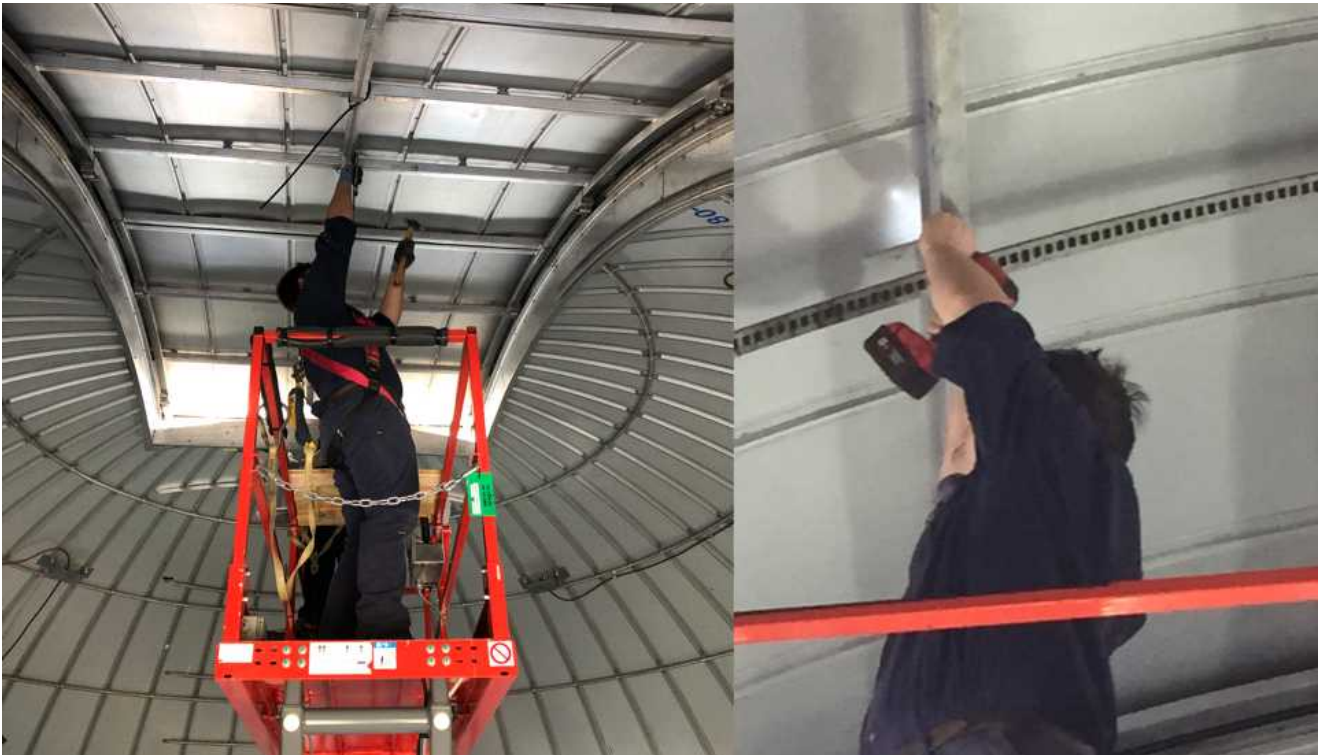
그림 6. 셔터랙을 타이밴드로 임시 고정 한 모습과 최종 고정하는 모습
