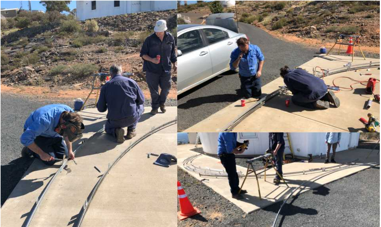
그림 5. 셔터랙의 고정탭을 제거한 후 새로운 위치에 용접하는 모습
