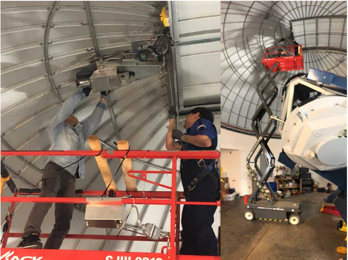
그림 7. 돔 드라이브장치를 제거하기 위해 설치한 와이어로프
