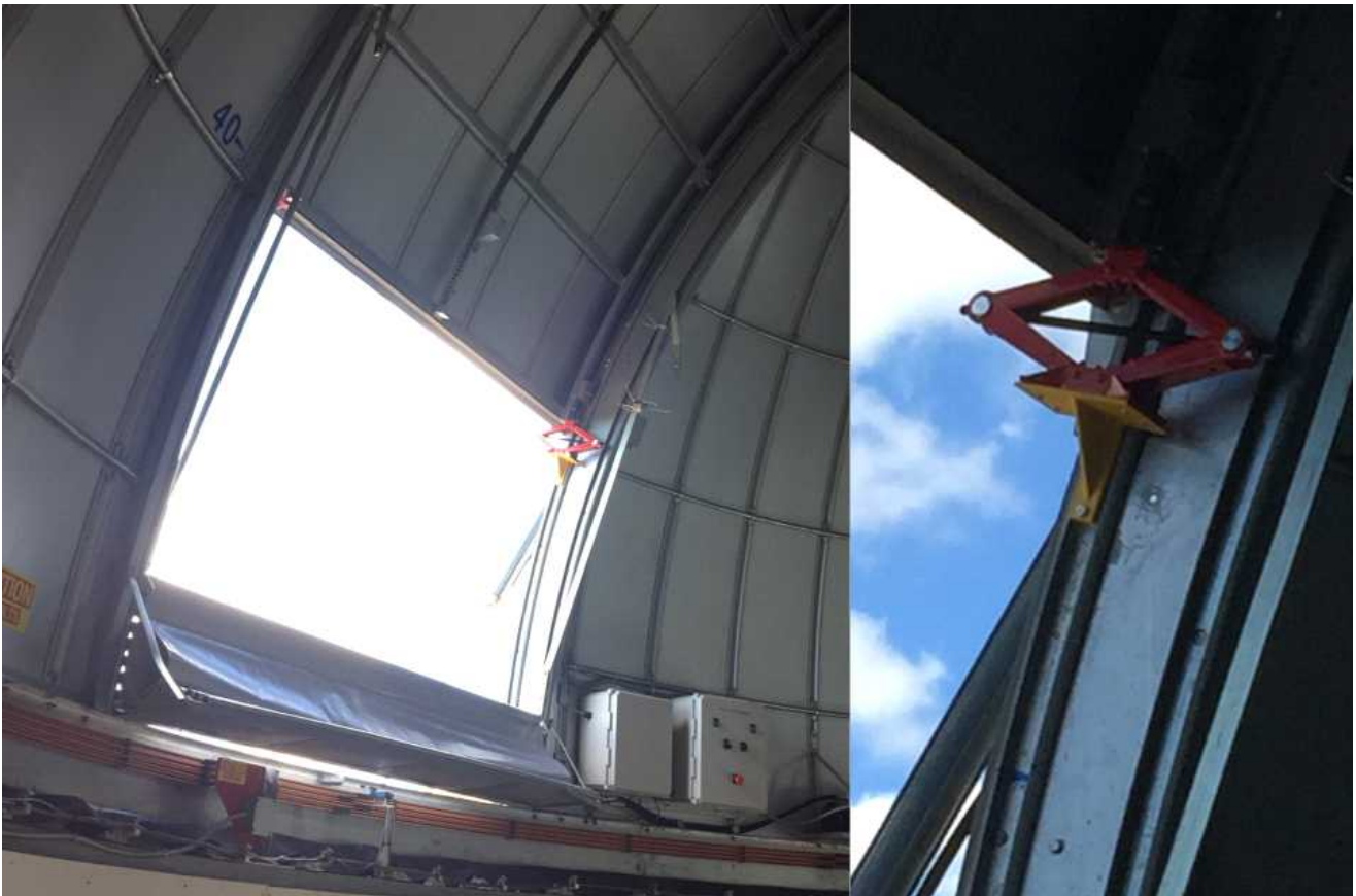
그림 4. 리프팅잭을 돔 가이드레일에 설치한 모습
