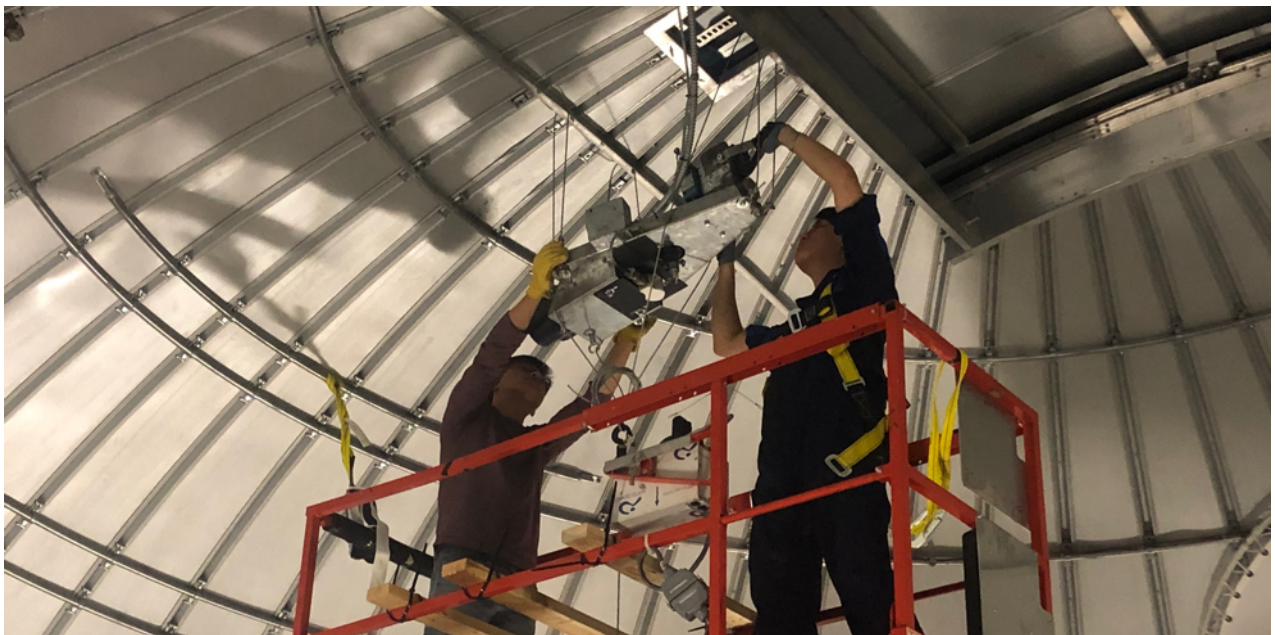
그림 4. 돔 셔터 기어 상태를 점검하기 위해 셔터 구동부를 내리고 있는 모습
