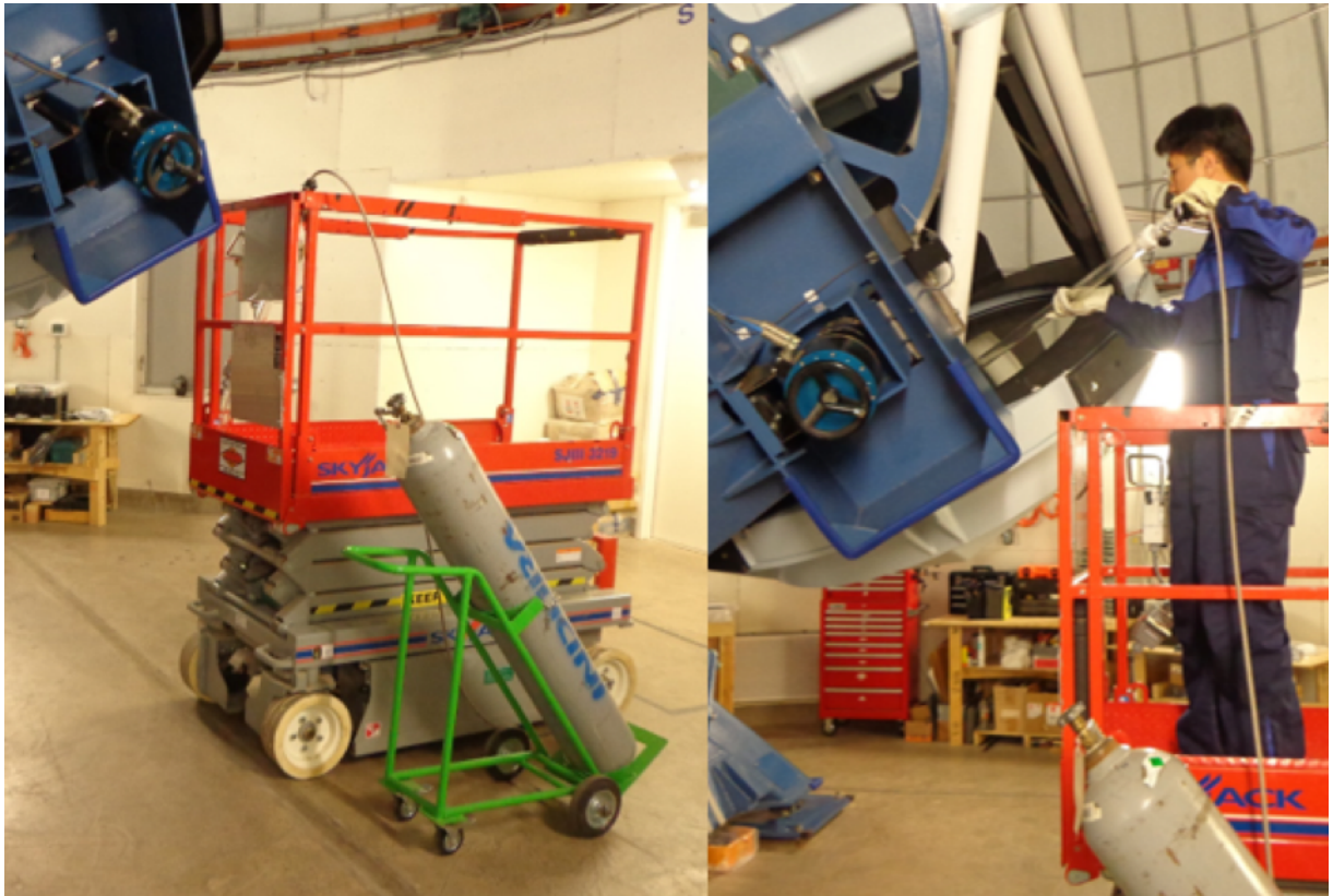
그림 10. 주경 면 청소를 위한 CO2 실린더와 고소작업대 위치(좌)와 작업 장면(우)
