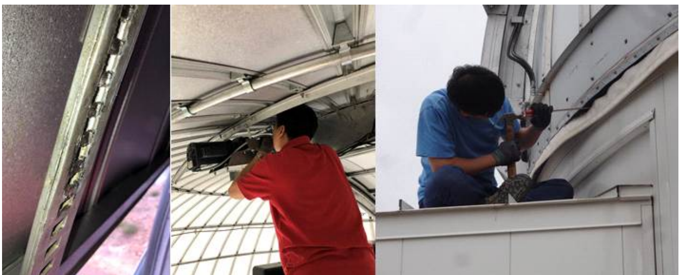
그림 5. 돔 셔터부 레일이 닳아서 패인 모습(왼쪽). 돔 셔터부 점검(중앙). 찢어진 돔 스커트 수리(오른쪽)
