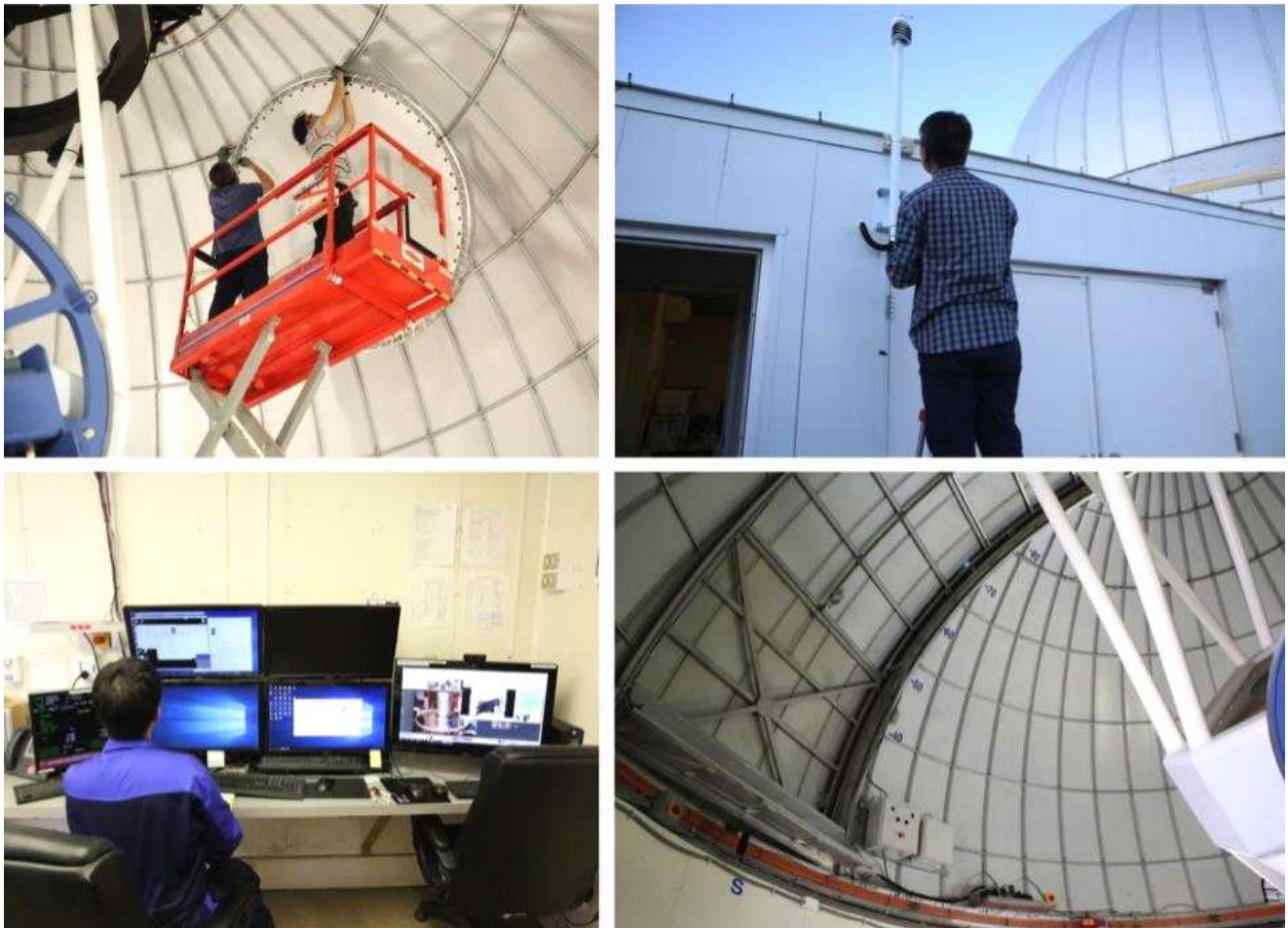
그림 8. 돔플랫폼 스크린(위 왼쪽)과 기상장비(위 오른쪽) 설치 모습. 벽면에 설치 고정된 GPS시계와 모니터(아래 왼쪽) 및 돔 셔터 고도를 알려주는 레터링(아래 오른쪽)
