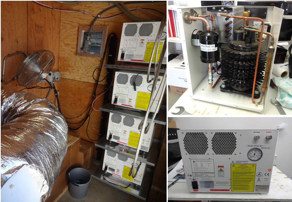
그림 23. CCD 카메라 듀어 냉각기 콤프레서 작업
