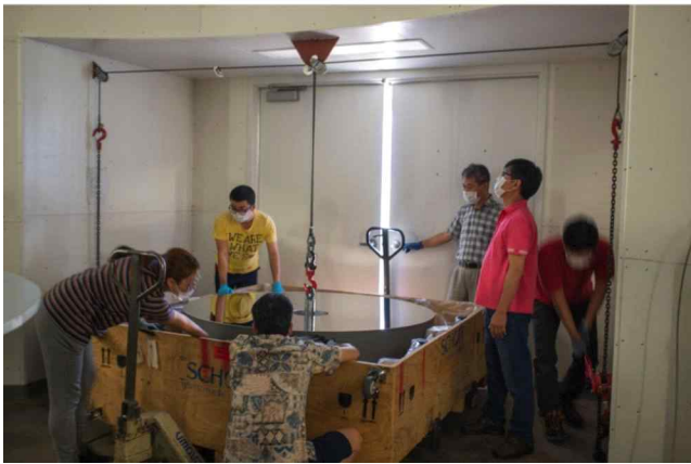
그림 12. KMTNet 돔내에 설치된 체인블럭을 이용하여 미러셀을 미러에 설치하는 과정
