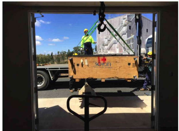
그림 11. 코팅을 마친 거울을 KMTNet돔으로 이동하는 과정
