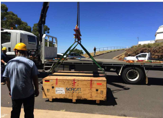
그림 3. 미러셀에서 미러 분리 후 미러박스에 포장하여 KMTNet돔에서 UKST 로 이동
